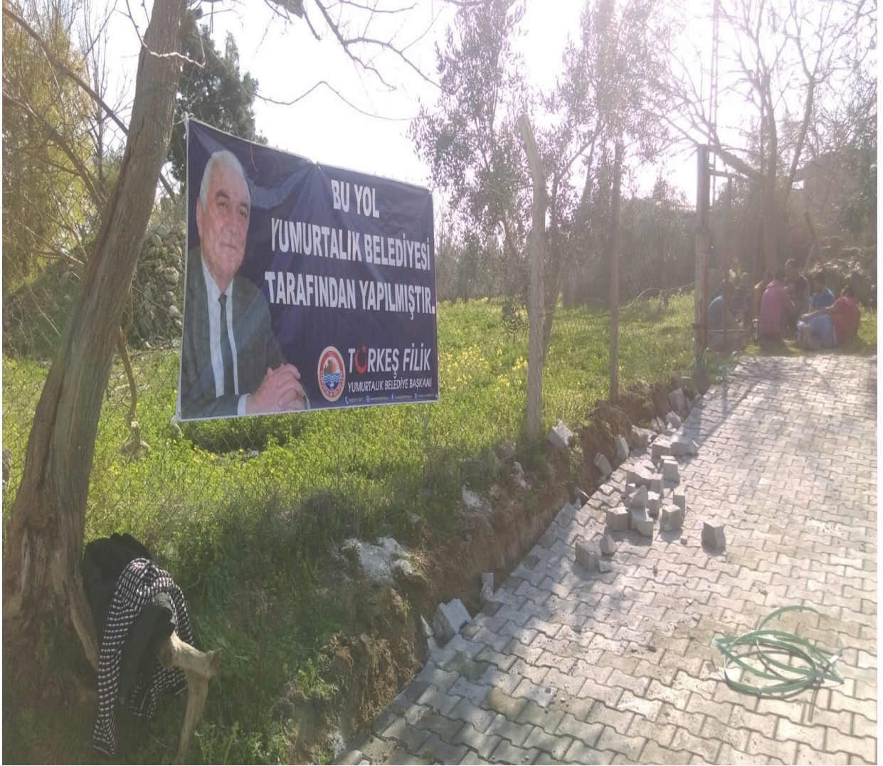
MUHTELİF MAHALLELERDE KİLİT PARKE TAŞI DÖŞEME İŞİ
