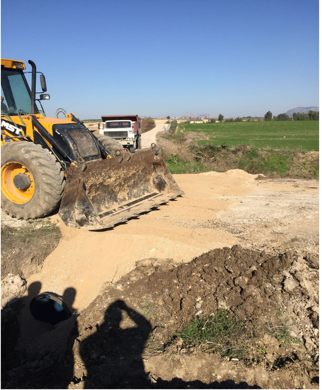
Tahiriye asmalı mahallesi arası menfez yapımı
