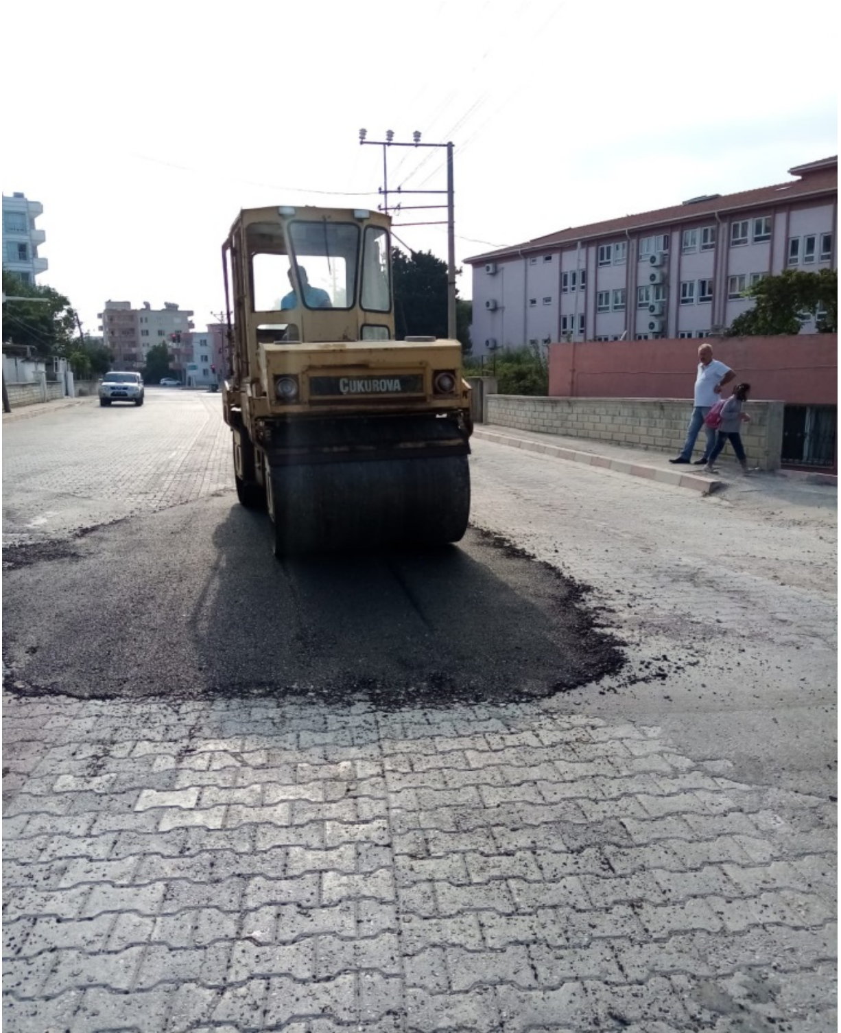
MUHTELİF MAHALLELERDE ASFALT YAMA YAPIM İŞİ
