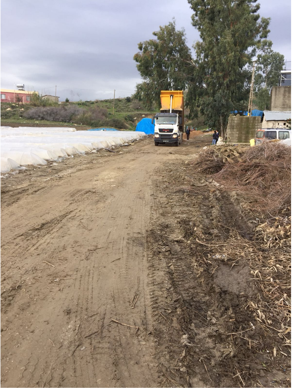
BOZULAN YOLLARA BAYPASS KAPLAMA İŞİ
